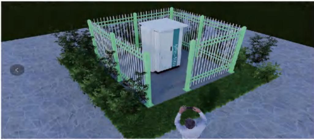
花溪河为长江的一级支流，发源于巴南区南彭街道花土湾。由东南流向西北，经南彭街道、界石镇、南泉街道、龙洲湾街道、花溪街道、李家沱街道等，于李家沱街道马王坪处注入长江。花溪河全流域面积268.46km<sup>2</sup>，河道总长66.25km，自上而下主要有冷水沟、甘家湾支流、八仙桥支流、尹氏祠支流、小泉支流等多条支流。花溪河流域水环境综合整治项目智慧水务工程水质监测系统建设包含考核断面监测站（18处）监测COD、氨氮、总磷、DO，辅助考核断面监测站（3处）监测COD、氨氮、总磷，移动监测（2处）监测COD、氨氮、总磷。
