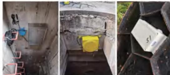
液位监测      有害易爆气体监测      井盖位移监测
